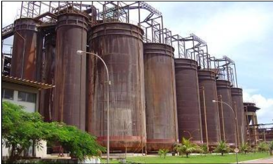
Figura 2.7 – Precipitadores. Fonte: Alunorte (2008).
