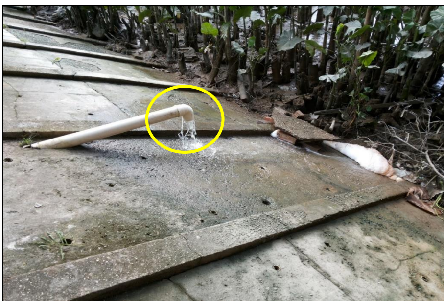
Figura 21 - Adaptação de tubo de PVC para coleta de amostras
