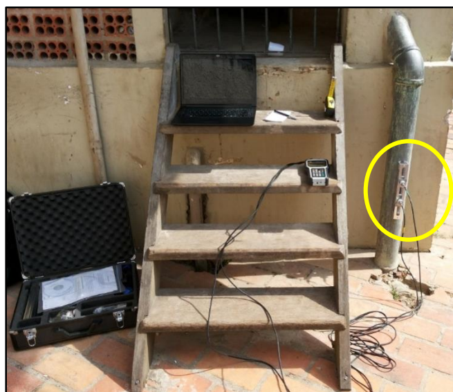
Figura 12 - Ponto de instalação dos transdutores
