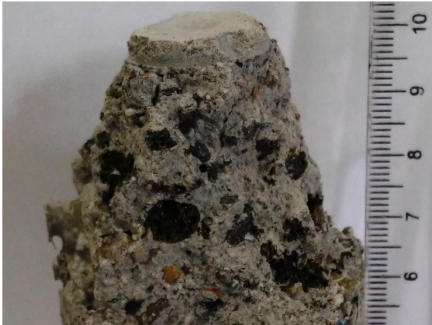
Figura 5.35 – Ruptura ocorrida no concreto
